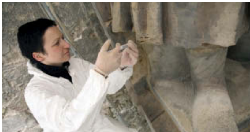
Filigrane Arbeit am Sandsteinkoloss. Steinmetzin und Restauratorin Corinna Grimm setzte unter der Bauplane an der Ostseite des Roten Turmes Spachtel und Knüpfel, Spritze und Pinsel ein, um den schönen Roland für die nächsten Jahrzehnte fit zu machen. Das Schwert fehlt hier noch, es ist nun mit einer Edelstahlhalterung befestigt.
