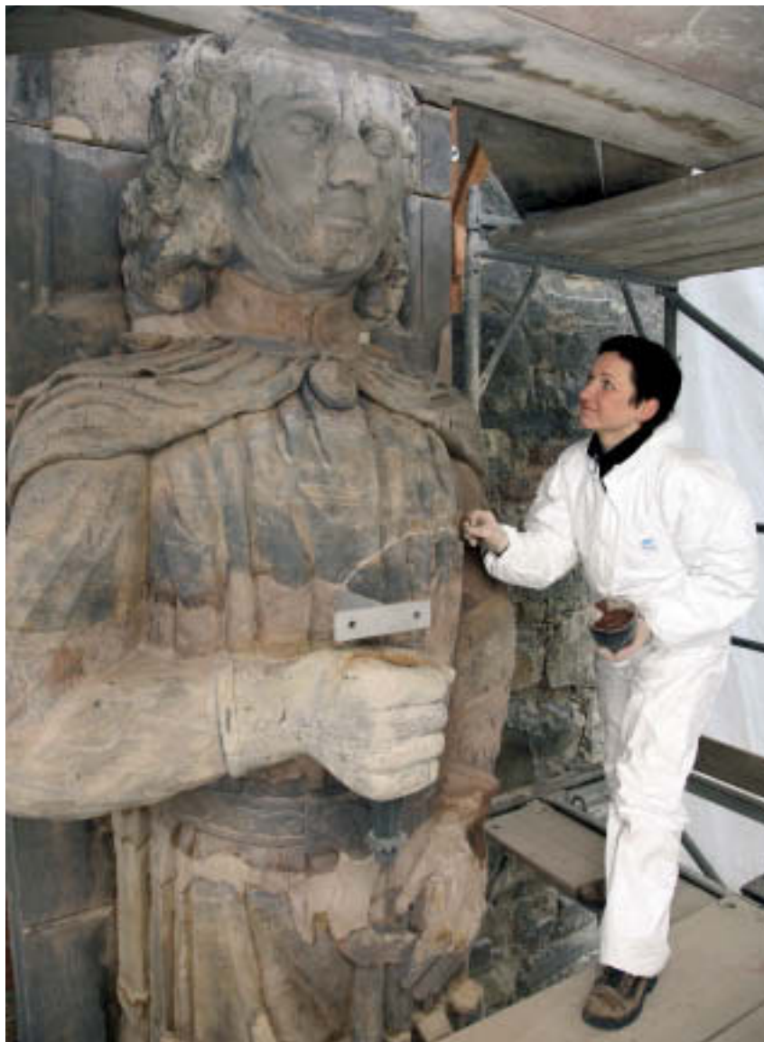
Filigrane Arbeit am Sandsteinkoloss. Steinmetzin und Restauratorin Corinna Grimm setzte unter der Bauplane an der Ostseite des Roten Turmes Spachtel und Knüpfel, Spritze und Pinsel ein, um den schönen Roland für die nächsten Jahrzehnte fit zu machen. Das Schwert fehlt hier noch, es ist nun mit einer Edelstahlhalterung befestigt.
