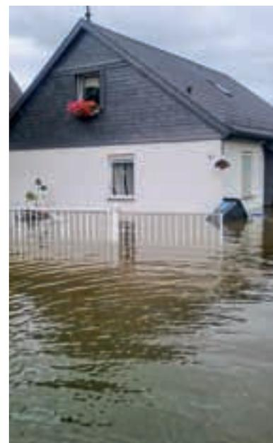
*Der Fluss Unstrut hatte das Erdgeschoss des Fertigteilhauses bis auf Kniehöhe überflutet. Danach blieb nur der Abriss.*
